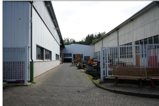
Bild B.2: Tor Lackierhalle (im hinteren Bereich zwischen den beiden Hallen)
